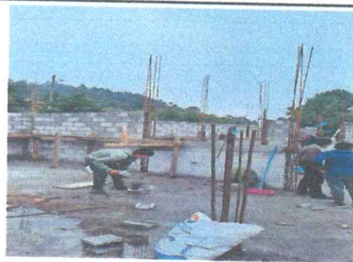
Foto 4: Levantado de paredes.
