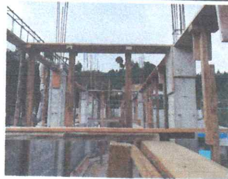
Foto 6: Fundición en proceso de finalización.
