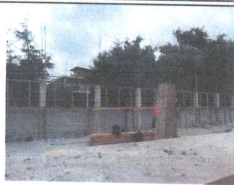
Foto 2: Preparación del área a mejorar.
