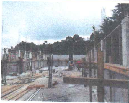
Foto 5: Mejoramiento de paredes en aulas, fundición de columnas en aulas a mejorar.
