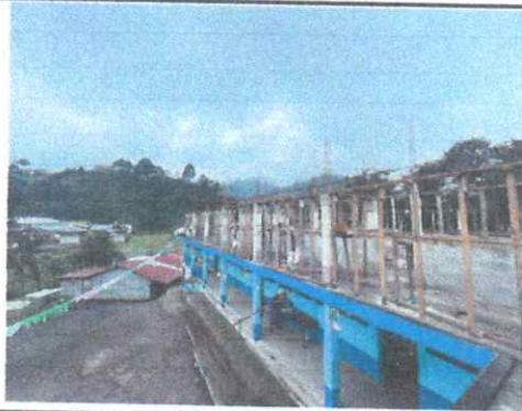
Foto 3: Colocación de madera para empezar las fundiciones
